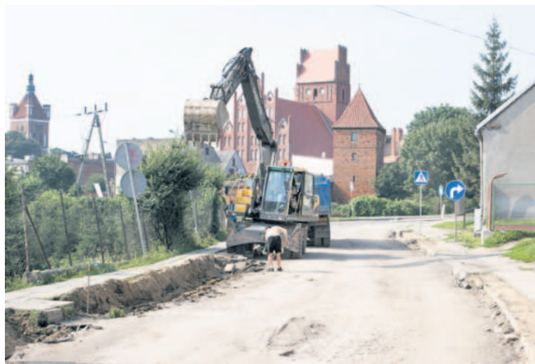
W ciągu ostatnich lat starostwo wyremontowało między innymi ulicę Brodnicką
