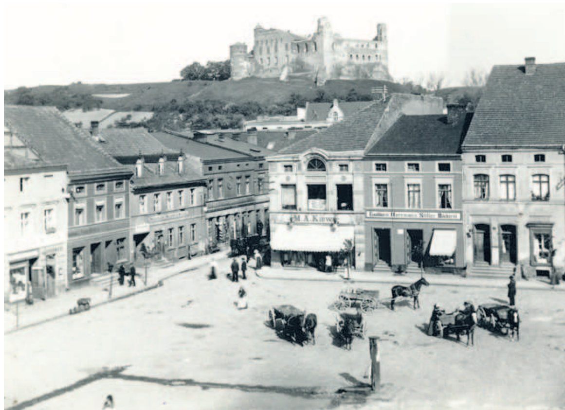
Przedwojenne zdjęcie z widokiem na dom handlowy
