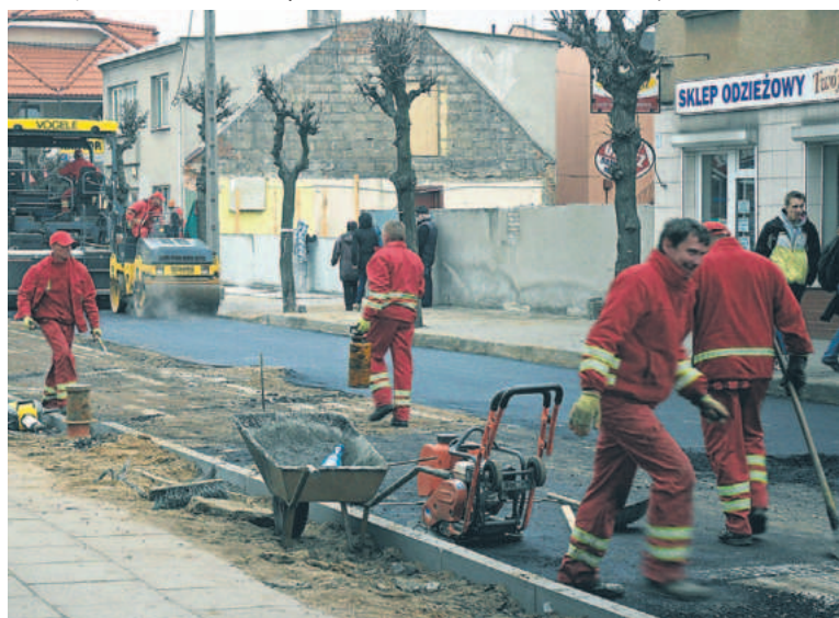
Wylewanie nowego asfaltu na ul. Kosciuszki
