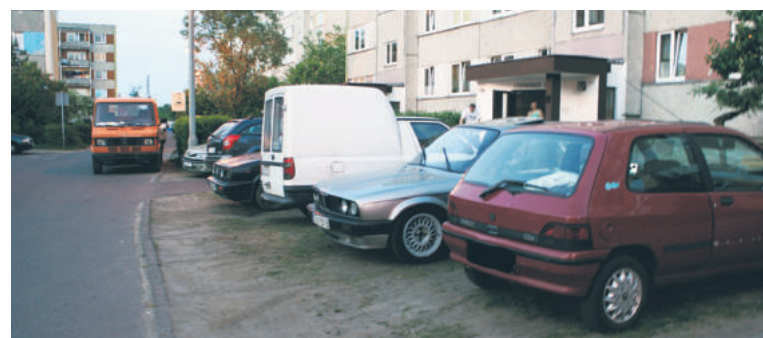
Poniedziałek godzina 21.00. Przy bloku przy ulicy Żeromskiego 30, kilkanaście samochodów parkuje na trawniku
