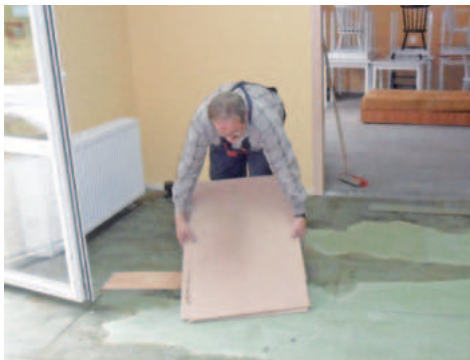
Usuwane są zniszczone przez sierpniowe zalanie panele
