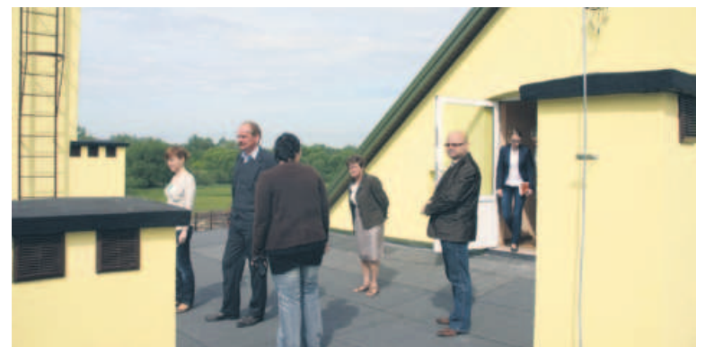
Ciekawym miejscem odkrytym podczas remontu jest wyjście na dach
