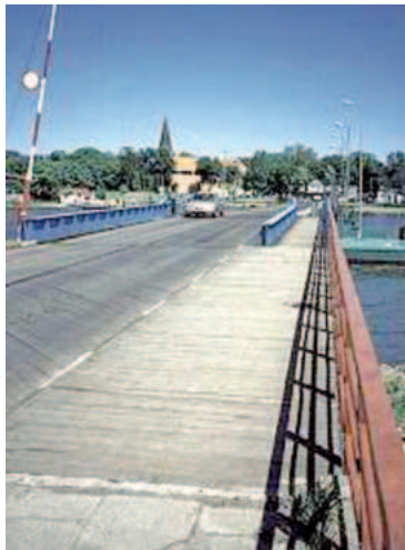
Na Wyspę Sobieszewską możemy dostać się mostem pontonowym lub promem
