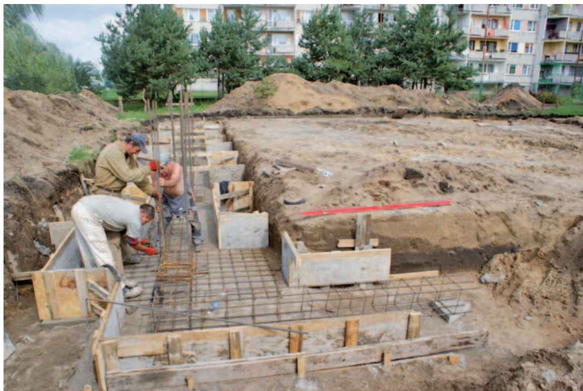
Przy Zespole Szkół nr 3 trwają prace przy budowie nowej sali gimnastycznej
