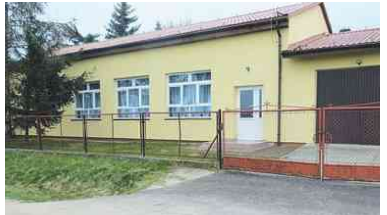
Miejscem, w którym spotykają się mieszkańcy sołectwa jest świetlica wiejska
