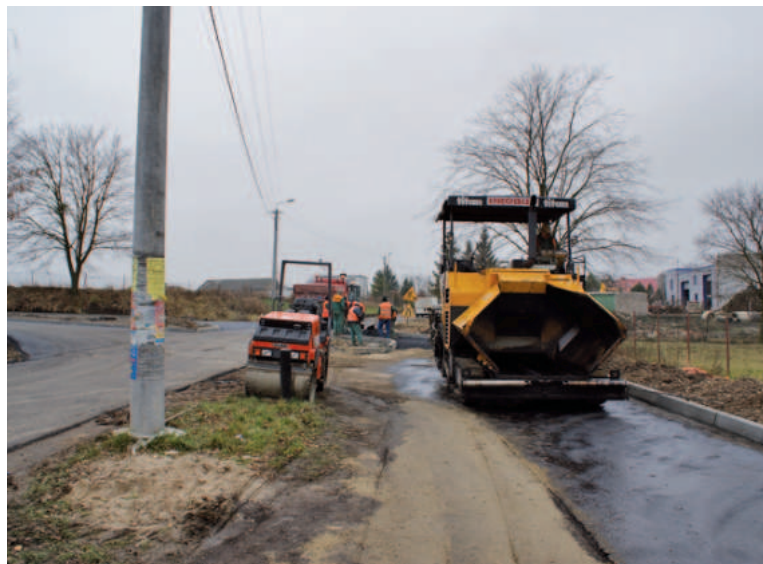
Jeszcze w tym roku zostanie ukończona przebudowa centrum Lisewa
