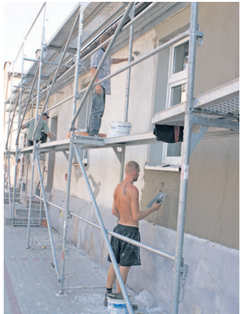
Przy jednej z kamienic przy ulicy Kilińskiego trwają prace remontowe. Odnawiana jest elewacja budynku. Wcześniej odnowiono kilka innych budynków w mieście, między innymi przy Rynku.
