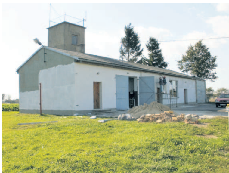
Remont świetlicy zakończy się w przyszłym roku
