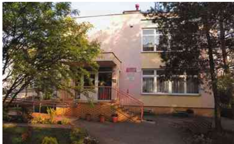
Budynek przedszkola ma zostać docieplony
