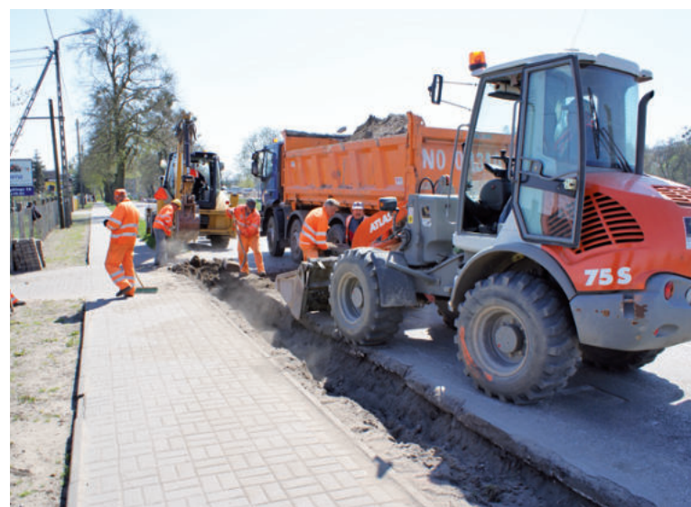
Rozpoczęły się prace na ulicy PTTK. Góra zamkowa jest zamknięta
