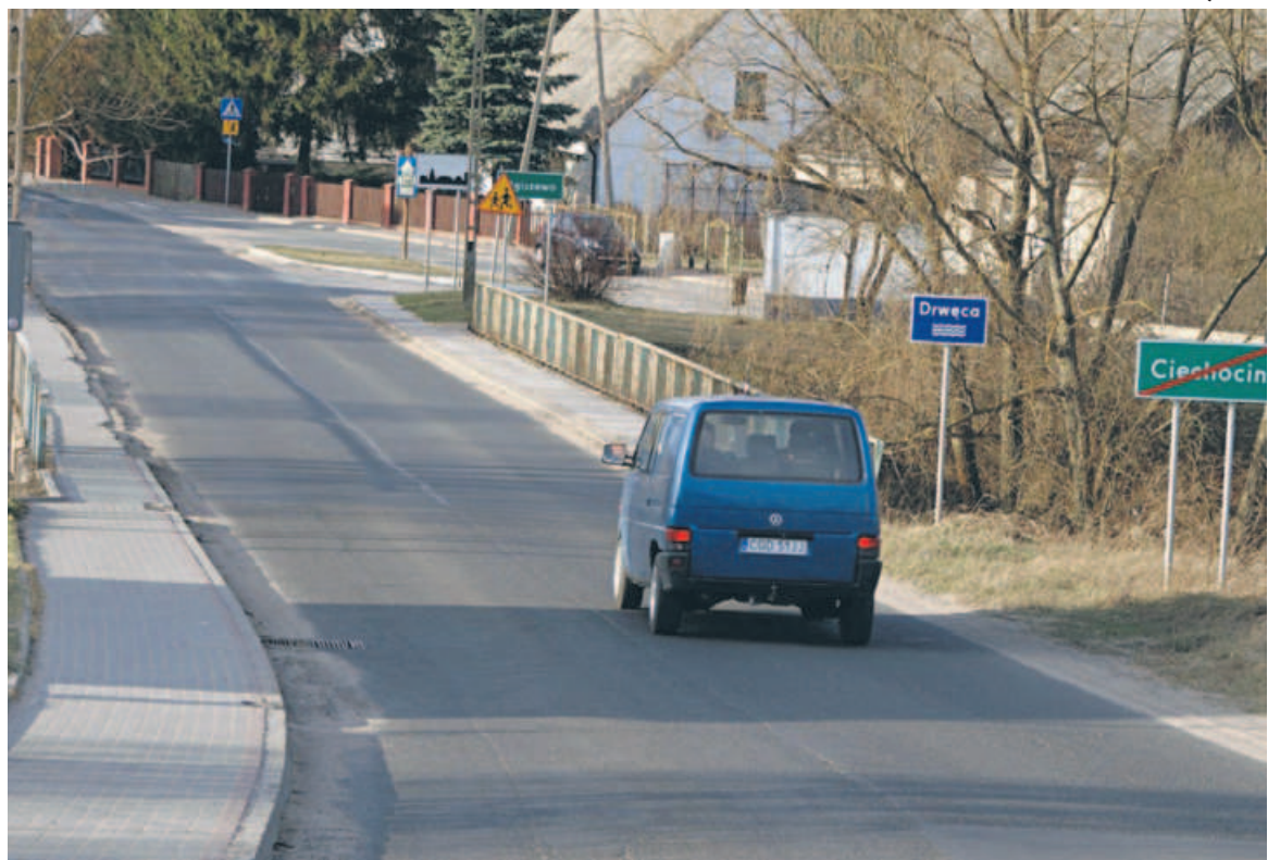
Niebawem ruch na moście będzie regulować sygnalizacja świetlna
