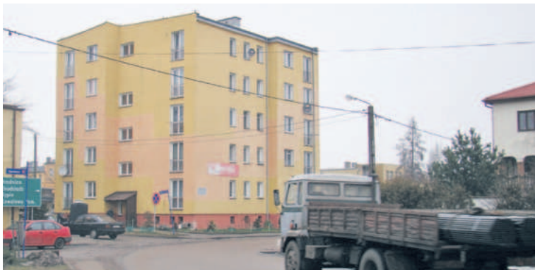
Jeszcze widać uszkodzenie elewacji po ostatnim zdarzeniu
