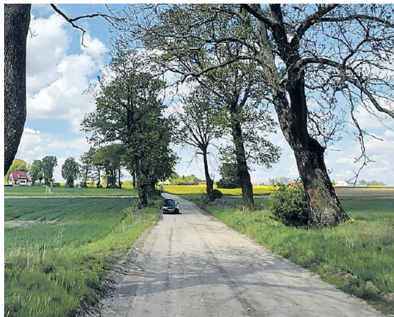
W Piórkowie powstanie prawie 900 metrów nowego asfaltu
