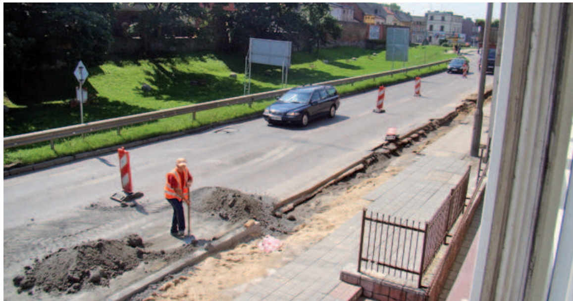
Remont ulicy PTTK przedłuża się. Dopiero w ostatnim tygodniu robotnicy weszli na ulicę Hallera
