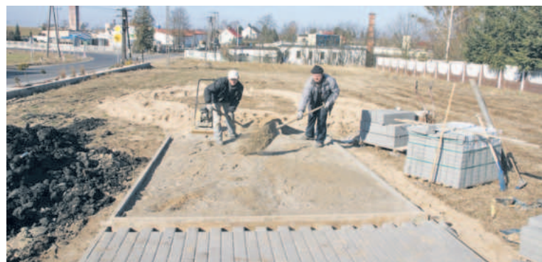
Aktualnie w centrum Ciechocina kładziony jest chodnik. Na końcowe efekty poczekamy do czerwca
