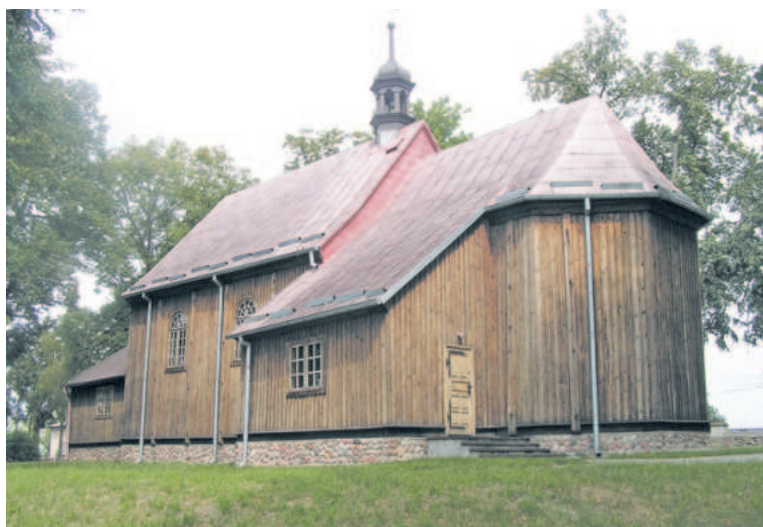
Dofinansowanie na remont zabytku otrzymała parafia w Dulsku
