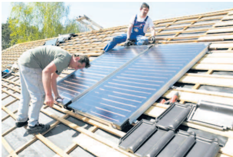
Montaż kolektorów słonecznych na dachu domu mieszkalnego
