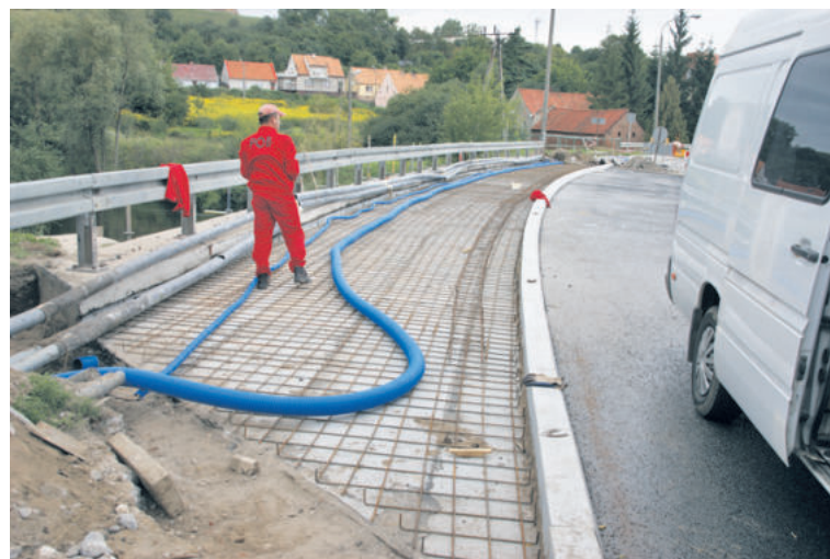
Ochrona dla instalacji telekomunikacyjnej już jest
