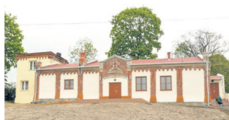
Nowo wyremontowana świetlica w Kikole
