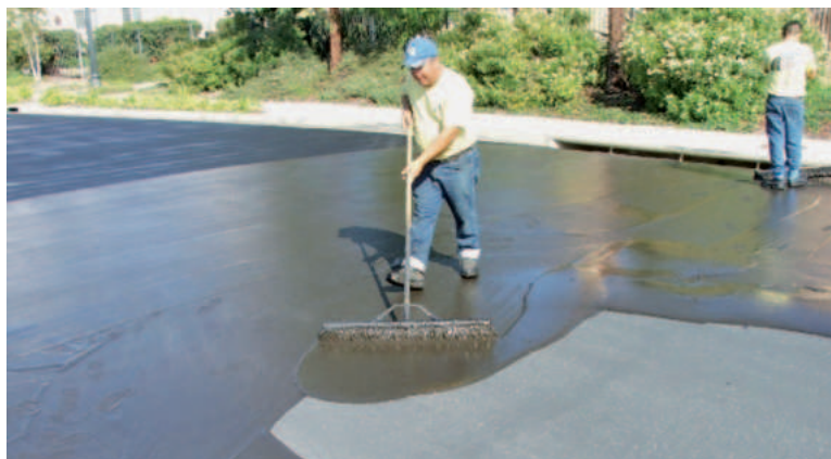
...i metodą slurry seal
