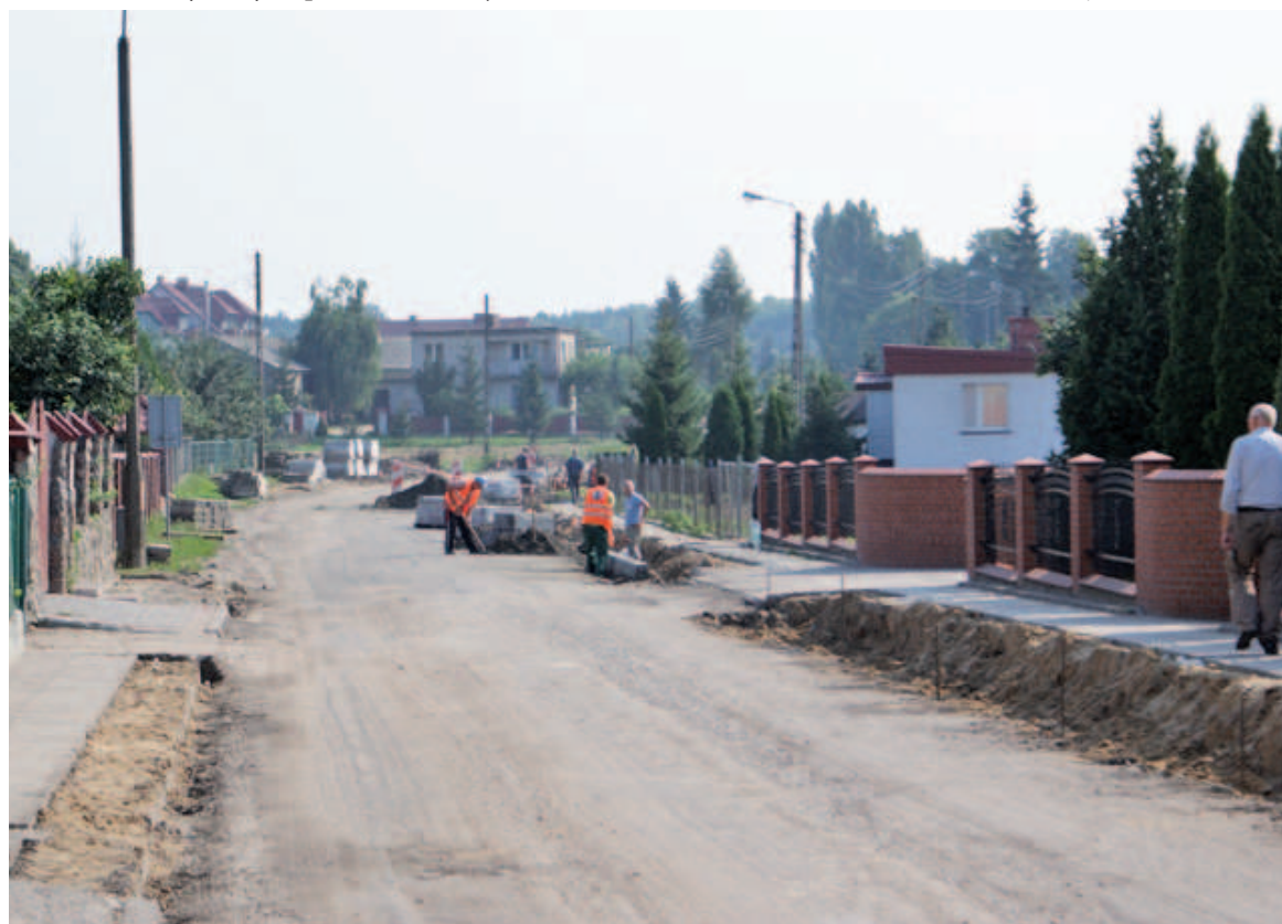
Remont ulicy Brodnickiej ma zakończyć się w tym miesiącu
