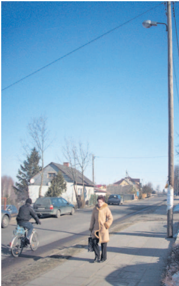
Czyja lampa? – gminy czy zakładu energetycznego?
