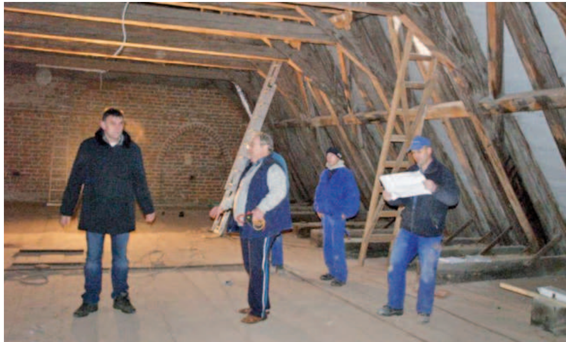
Kolejnym etapem prac będzie zaadaptowanie wnętrza wieży oraz przygotowanie ekspozycji historycznych
