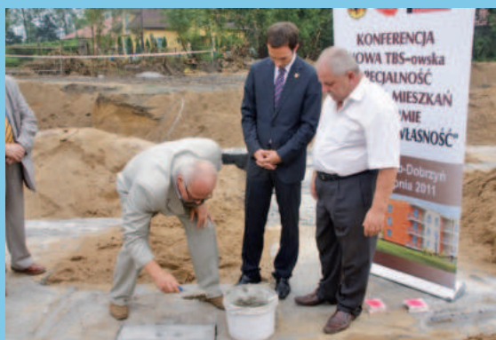
W Golubiu-Dobrzyniu rozpoczęła się budowa bloku RTBS
