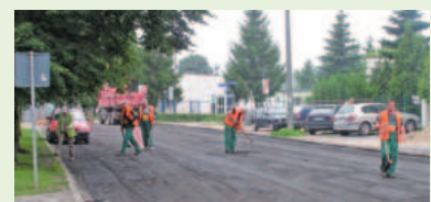
Rozpoczęły się prace wodno-kanalizacyjne w Golubiu-Dobrzyniu
