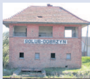
Wyburzono budynek nastawni w Golubiu-Dobrzyniu
