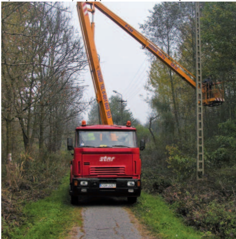
Po zakończeniu przycinania gałęzi, na Czarnej Drodze pojawi się ekipa sprzątająca. Remont nawierzchni nie jest ujęty w planach na najbliższe miesiące
