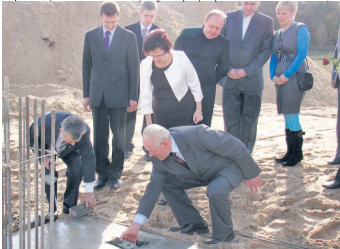
Wmurowanie w fundamenty powstającej hali sportowej „kapsuły czasu”
