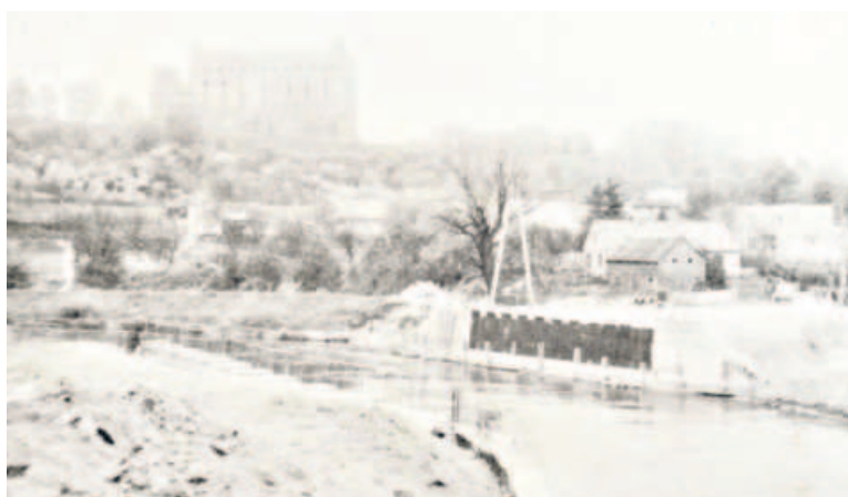
Budowę mostu rozpoczęto w połowie lat 80. ubiegłego stulecia
