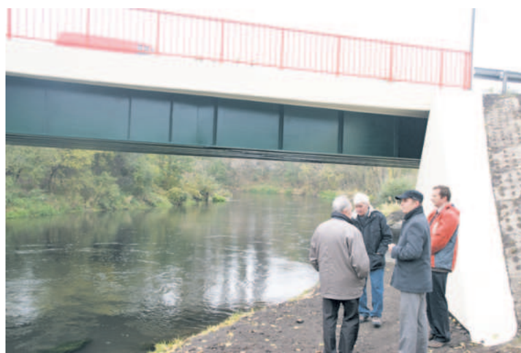
Wicedyrektor ZDW w Bydgoszczy sprawdza stan przyczółków mostowych
