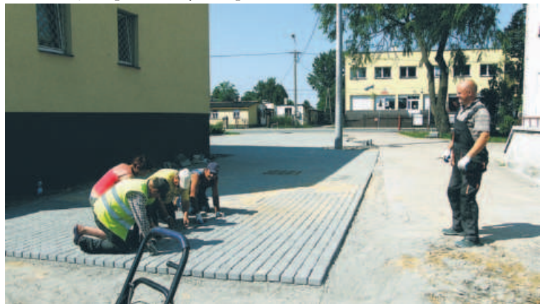
Ekipa remontowa podczas pracy.
