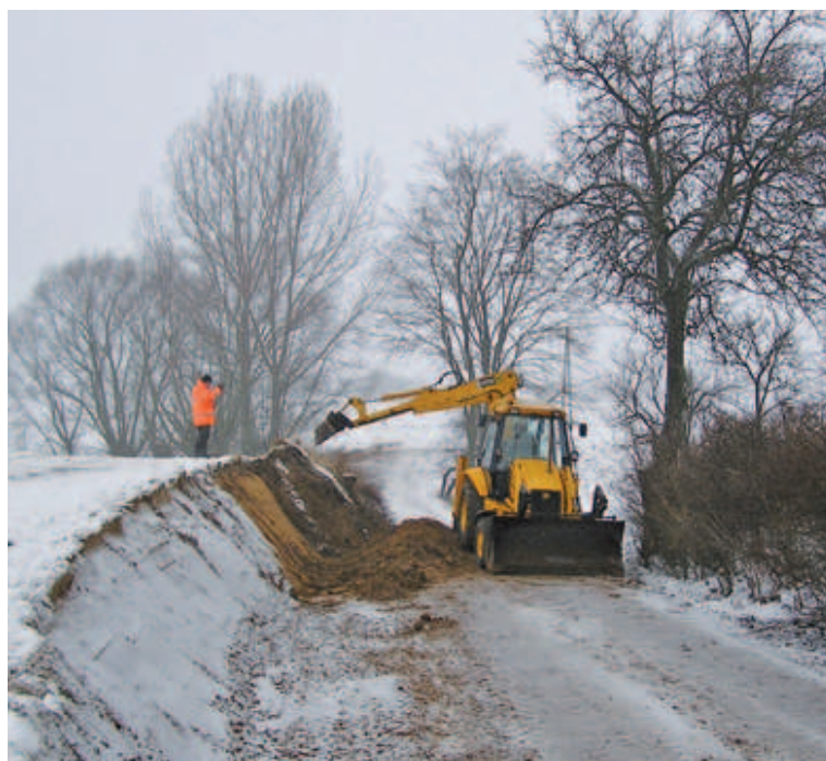
Porządkowanie skarp przy drogach gminnych
