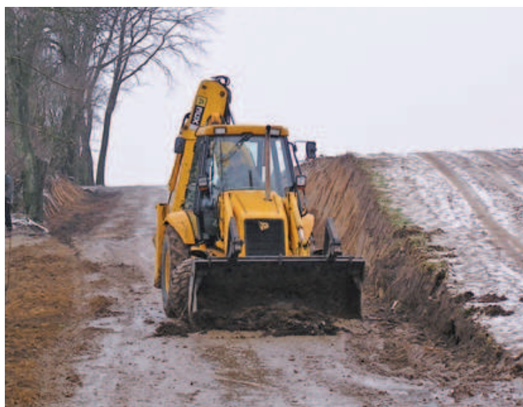
Radomin – poszerzona droga i uporządkowana skarpa
