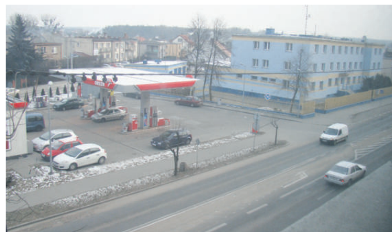
Ulica Piłsudskiego na kilkusetmetrowym odcinku w centrum miasta została pominięta przy poprzednim remoncie. W tym roku znalazła się już w budżecie ZDW
