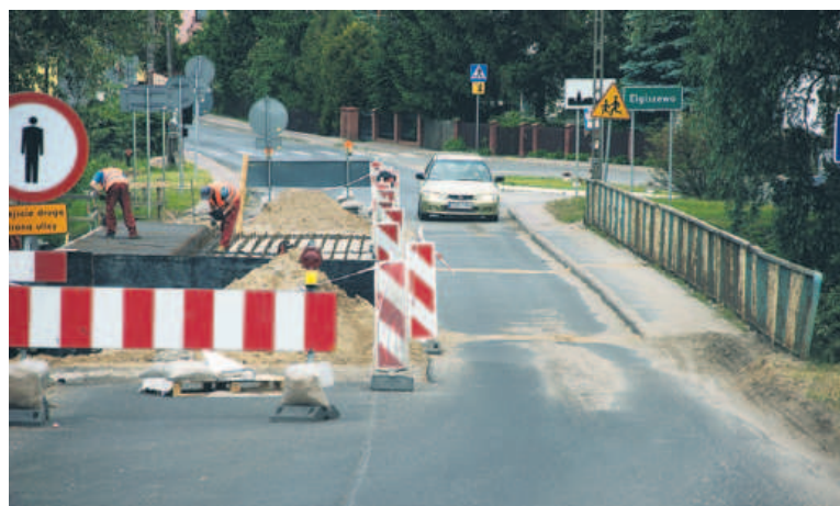
Robotnicy pracują obecnie na jednej połowie przeprawy. Koniec prac zapowiadany jest na połowę listopada
