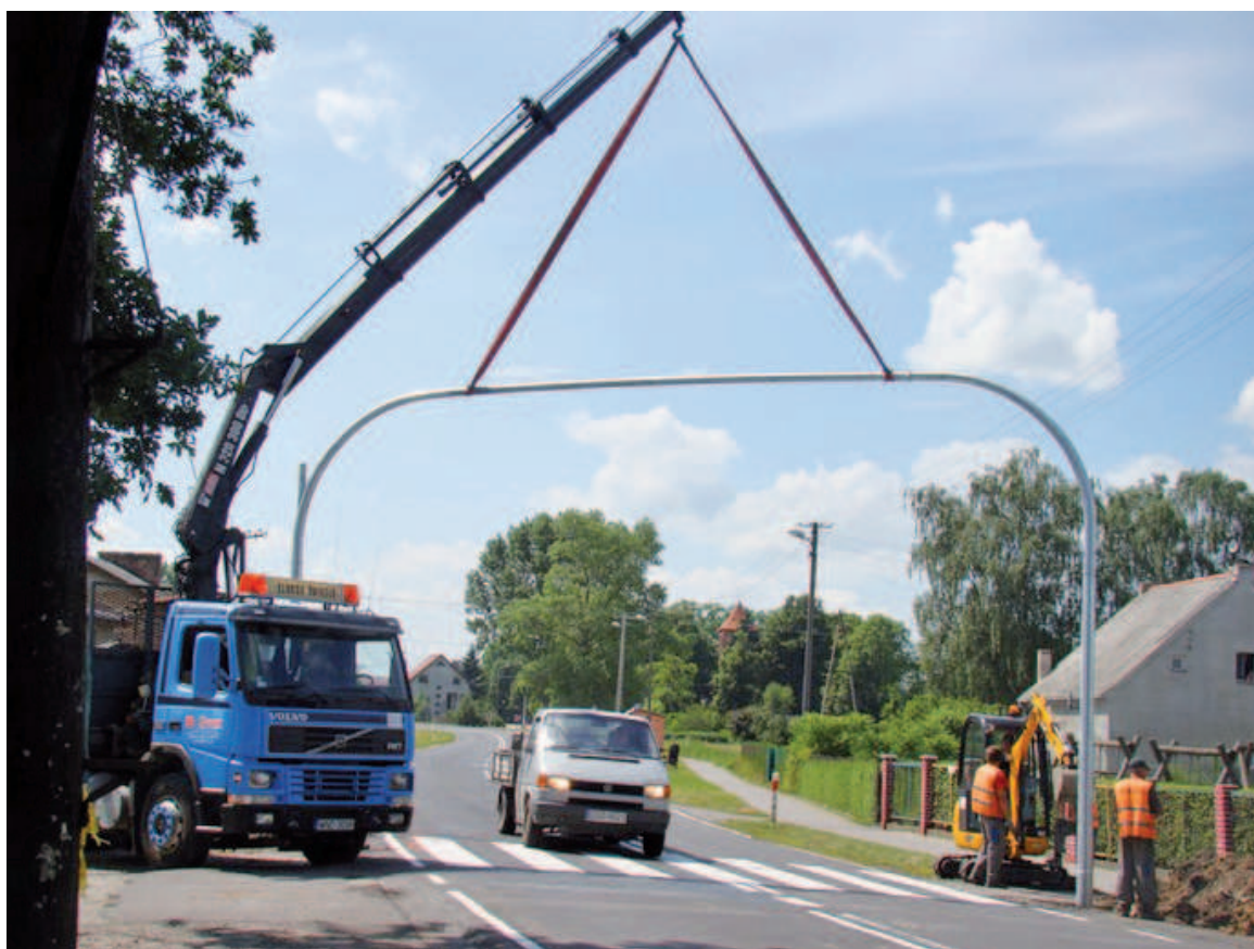
Sygnalizacja świetlna już została zamontowana
