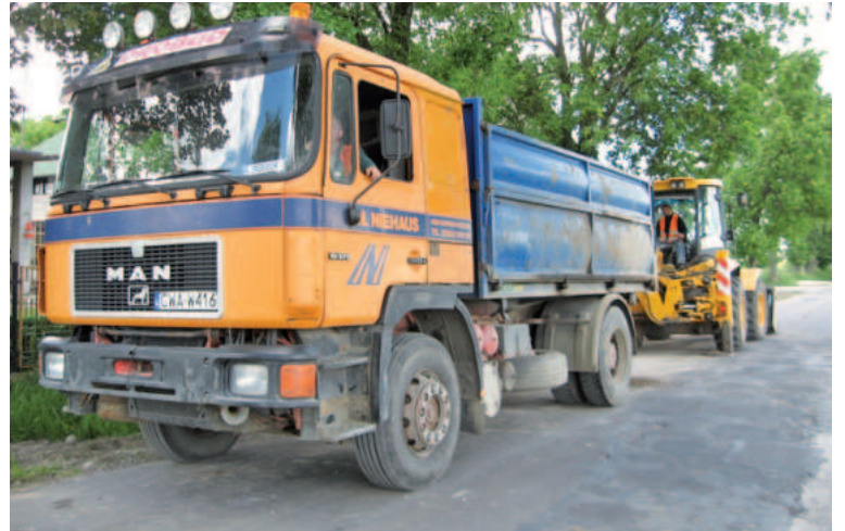
Prace remontowe trwają na wielu odcinkach dróg w powiecie
