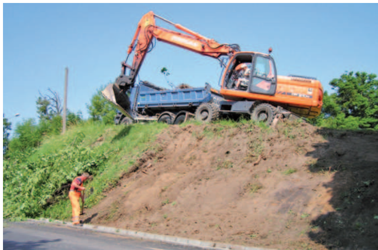
Pracownicy wyrównują wzniesienie przy wjeździe na zamek
