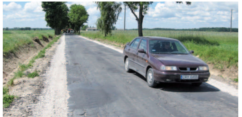
Przy drodze z Płonnego utwardzone zostanie pobocze
