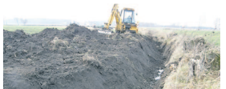
Trwają prace związane z udrożnieniem rowu
