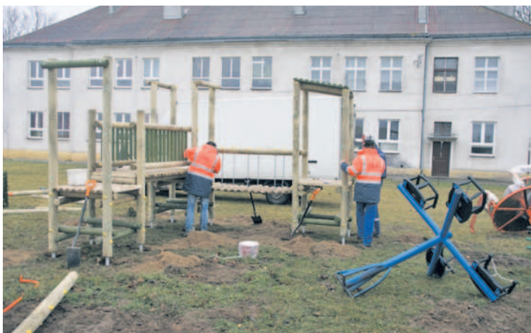
Plac zlokalizowany jest za budynkiem byłej szkoły w Miliszewach
