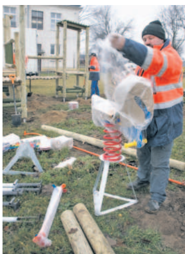
PW Rozpakowywanie i instalacja bujaka
