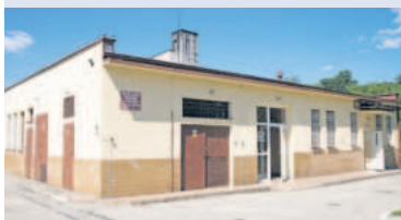
Adaptacja pomieszczeń przepompowni na biura MZWIK
