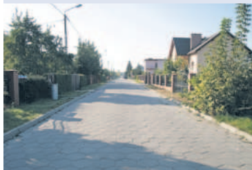
Utwardzenie ul. Brzozowej
