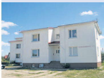
Budowa bloku przy ul. Malinowskiego
