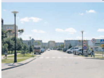
Budowa ul. Konopnickiej wraz z oświetleniem
