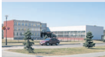
Budowa Szkoły Podstawowej nr 2 wraz z salą gimnastyczną
