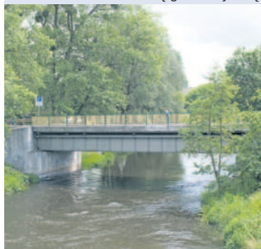
Kapitałny remont starego mostu
