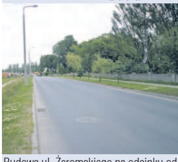
Budowa ul. Żeromskiego na odcinku od ul. Sokołowskiej do ul. Kościuszki
