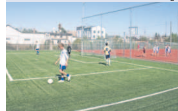
Budowa zespołu boisk sportowych ORLIK 2012
