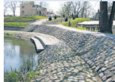
Budowa bulwaru nad Drwęcą
