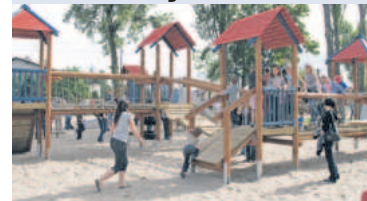
Budowa placu zabaw
