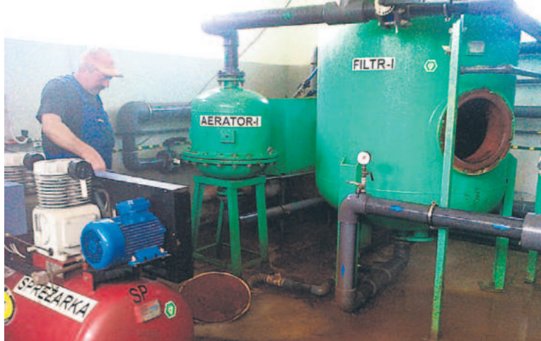
Prace w Dulsku polegały na regeneracji urządzeń służących do filtrowania wody
