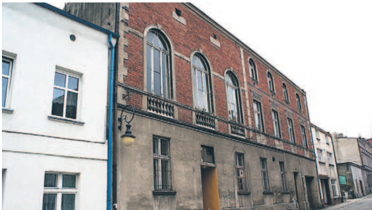
W poprzednim numerze zamieściliśmy zdjęcie budynku przy ulicy 17 stycznia w Golubiu
