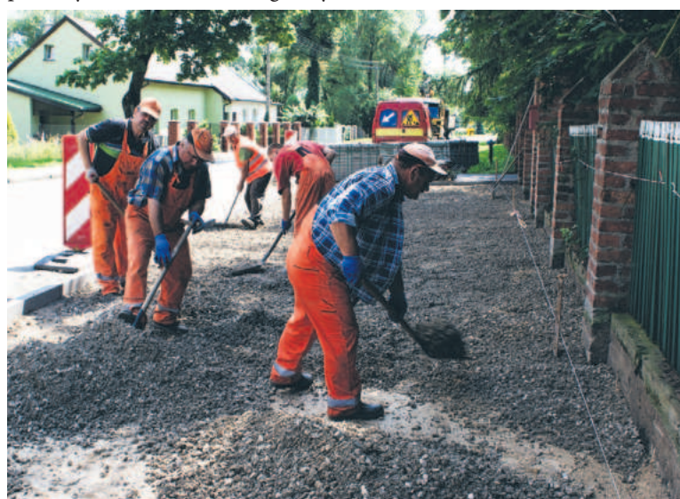
W Wielkiej Łące zostanie wyremontowanych i pobudowanych około 400 metrów chodnika
