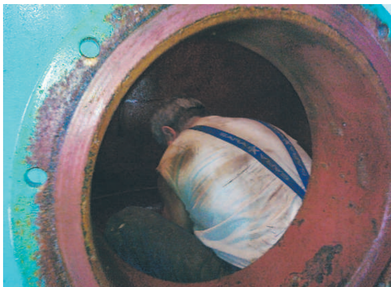
Konserwację należało przeprowadzić także wewnątrz filtra
