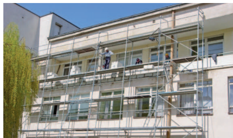
Prace przy wymianie okien w zeszłym roku
