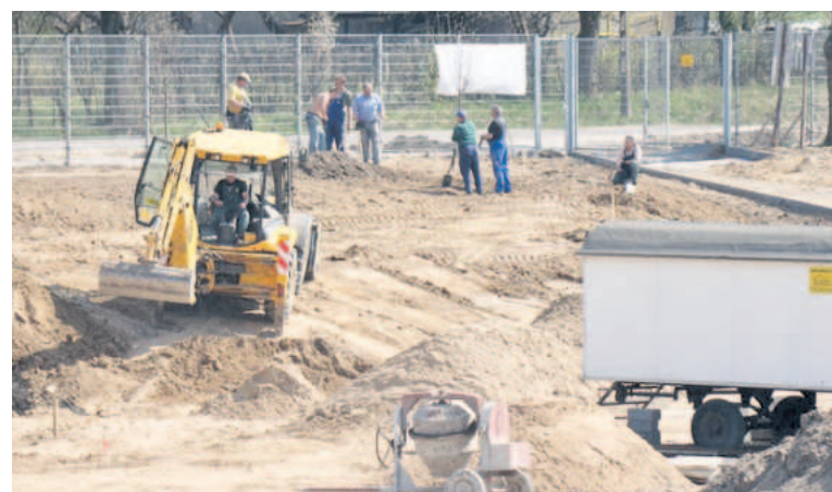
Prace przy wjeździe na stadion
