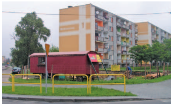
Przy ulicy Lipnowskiej powstaje budynek handlowo-usługowy
