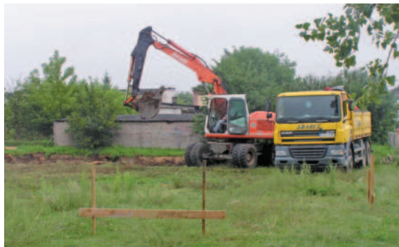
Przy ulicy Konopnickiej już trwają pierwsze prace
