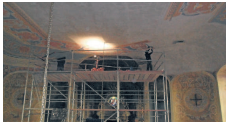
Tak wyglądały prace podczas malowania polichromii
