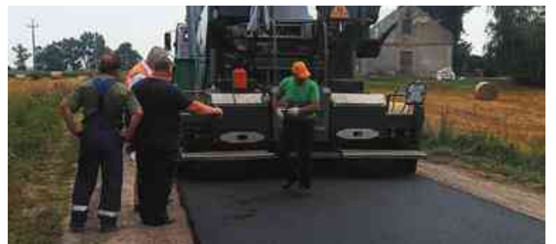
Adamki – Budowa drogi potrwa do 15 września
